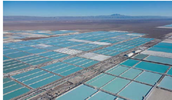
Khai thác nước muối ở Salar de Atacama bao gồm bơm nước mặn, giàu liti vào các ao bốc hơi. Bùn sau bay hơi được xử lý bằng các khoáng chất như natri cacbonat để chiết xuất liti. Ảnh: Hemis / Alamy Stock
